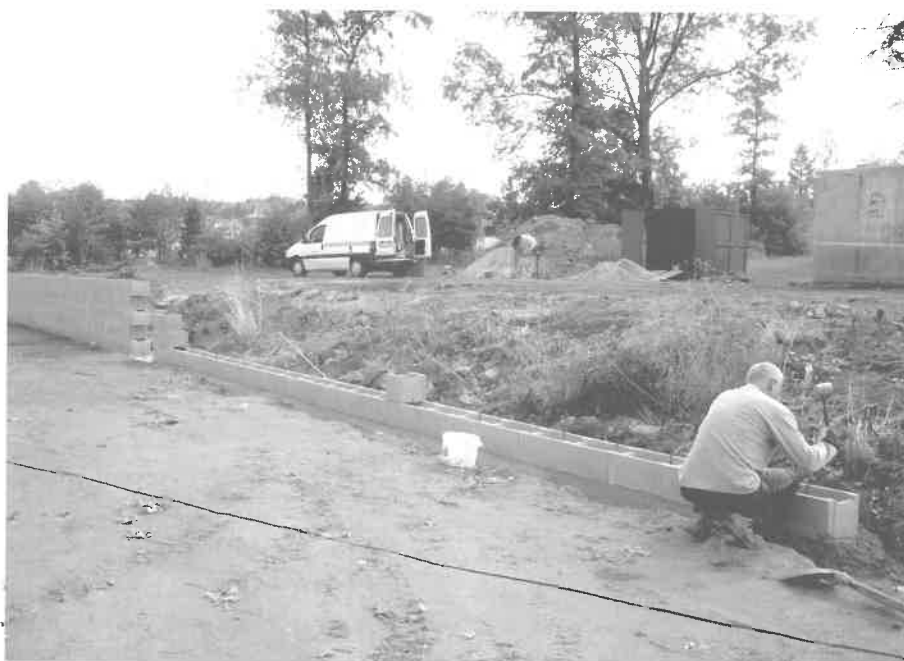
Rekonstrukce tenisových kurtů – foto: P. Havlová
