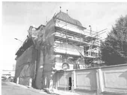
Dům čp. 6 pod lešením – foto: E. Klementová
